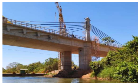
BR-235/MA/PI PONTE DE SANTA FILOMENA
