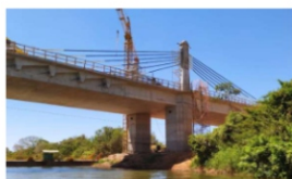
BR-235/MA/PI PONTE DE SANTA FILOMENA
