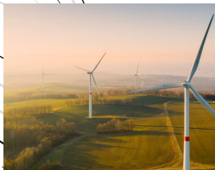
Geração de Energia
